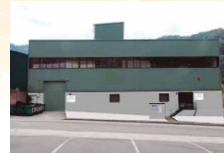
Unidad de Desarrollo de Materiales Multifuncionales (Sotroñdio, Asturias).
